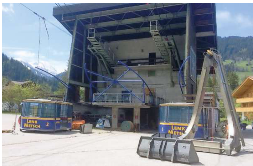
Die Standseilbahn wird abgebaut und die zwei Kabinen sollen versteigert werden.
